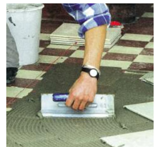
Nach ca. 3 Stunden können nachfolgende Oberbeläge aufgebracht werden.
