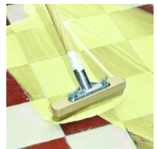
Grundierung auf dem Untergrund im „Kreuzgang“ vollflächig verteilen.
