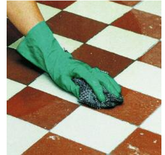
Untergrund mit geeignetem Reiniger (z. B. PCI Univerdüner) von haftungsmindernden Rückständen säubern.
