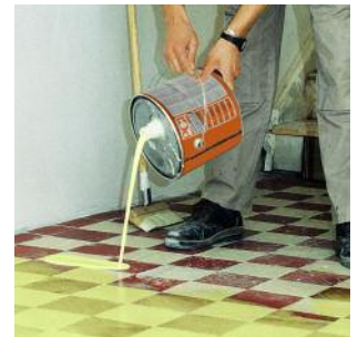
PCI Gisogrund 303 gründlich aufschütteln und auf den Untergrund ausgießen.
